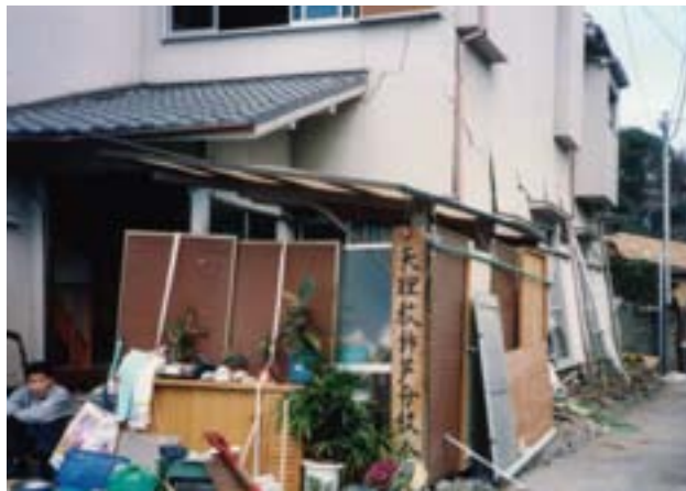
阪神大震災での被災状況
