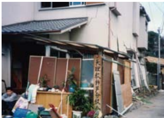
阪神大震災での被災状況
